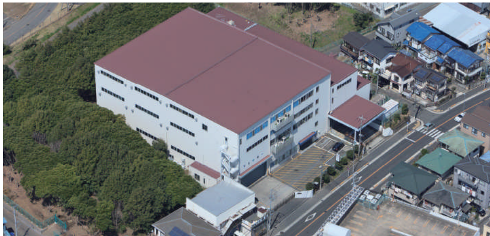
本社・大和物流センター
